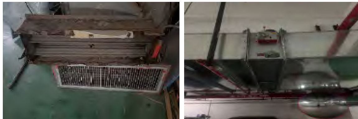
消防排烟风阀更换现场图
