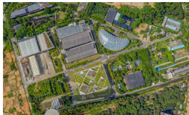
东莞建筑研究院俯视图(已大面积铺设屋顶光伏)
