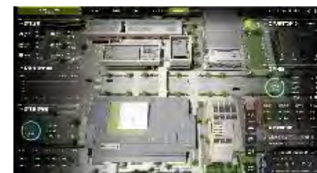
CIM中控平台—智能运维界面
